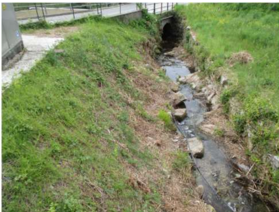
Veduta della tratta del Rio Piaggio a valle di Via Francioli, in cui si può apprezzare la differenza tra sponda sinistra e sponda destra, quest'ultima difesa da un muro in blocchi di pietrame
